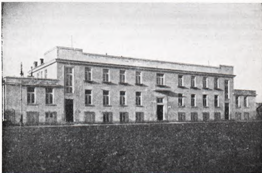
Budynek II Ośrodka Zdrowia i Opieki w Warszawie (ul. Opaczewska 1).
