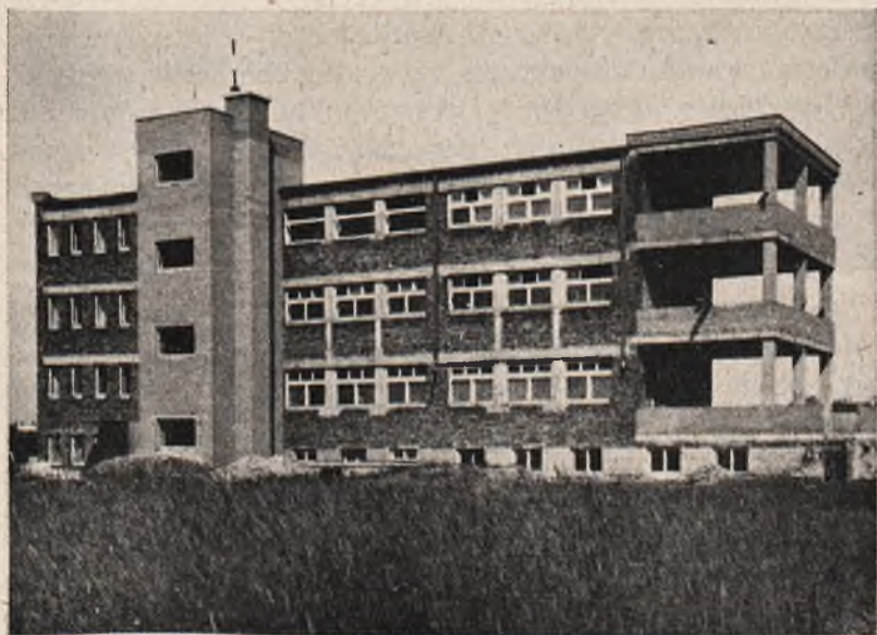
Budowa nowego Domu Matki i Dziecka w Warszawie. (Bielany, ul. Przybyszewskiego)
