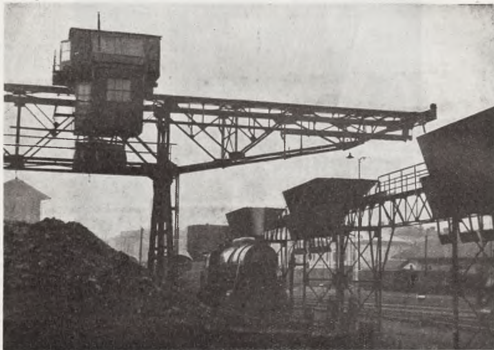
COAL LOADING APPLIANCES AT DZIERZYCIE
