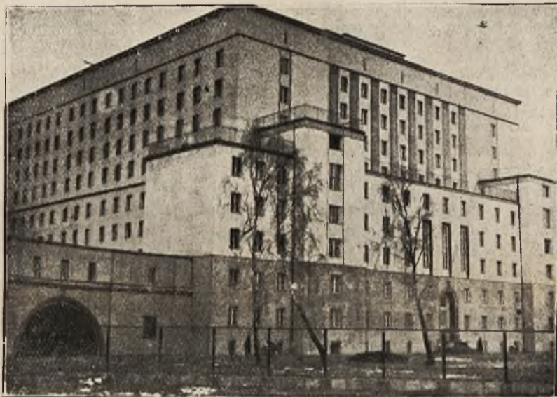
Centralny pawilon kolonii akademickiej przy ul. Grójeckiej w Warszawie. Kolonia, obliczona na 1700 mieszkańców mieści również szereg instytucji akademickich z N. K. A. na czele.
