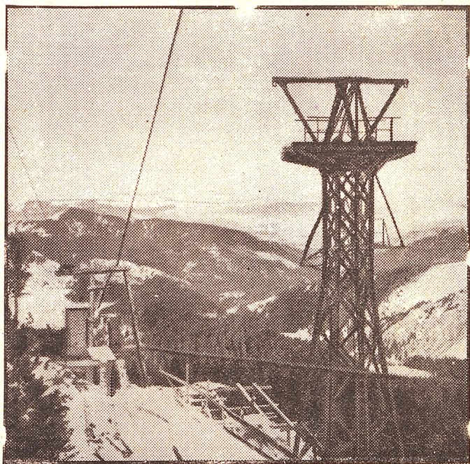
Wieża podporowa kolejki linowej na Kasprowy
