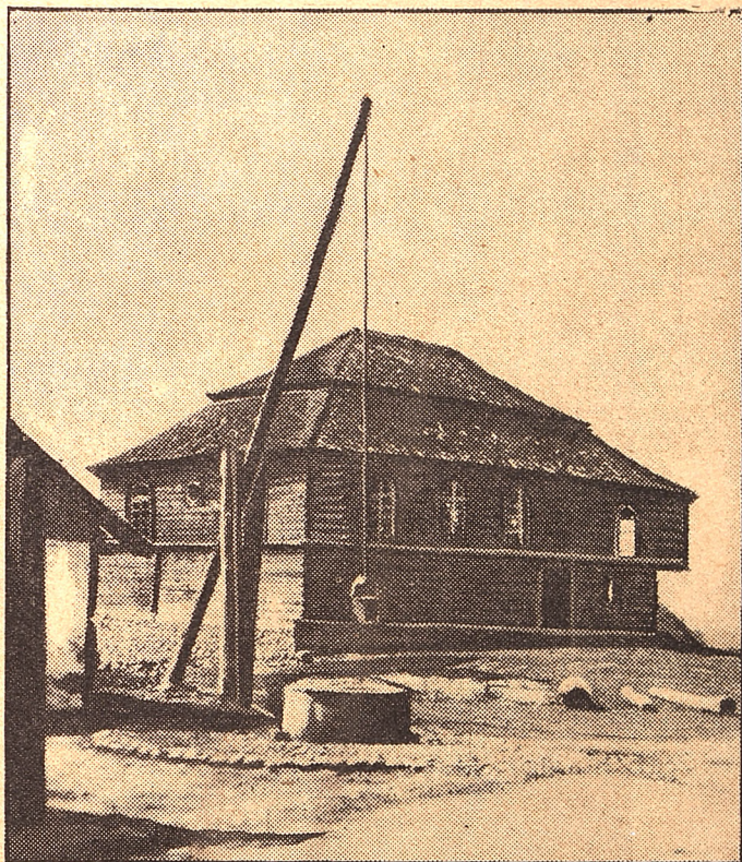
Stara, opuszczona buźnica w Nowogrodzie — zabytek dawnego budownictwa drzewnego
