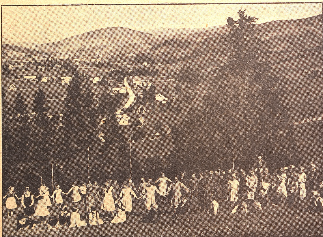
Widok ogólny na uzdrowisko w Wiśle.
