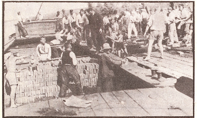
Wyładunek 200.000 cegły w „porcie potulickim“. Pracują wszyscy: bracia i klerycy.
