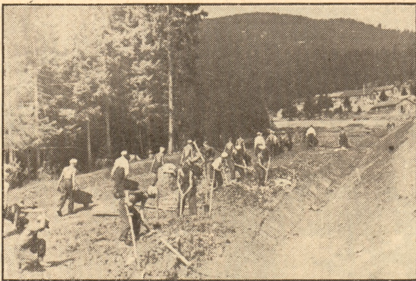
Junacy pracują przy budowie drogi w górach.
