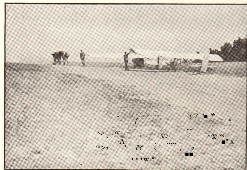
Transport szybowców z powrotem na stok odbywa się zapomocą liny, nawiniętej na dźwignię. Konie, schodząc w dół, wciągają szybowiec na górę po zboczu.
