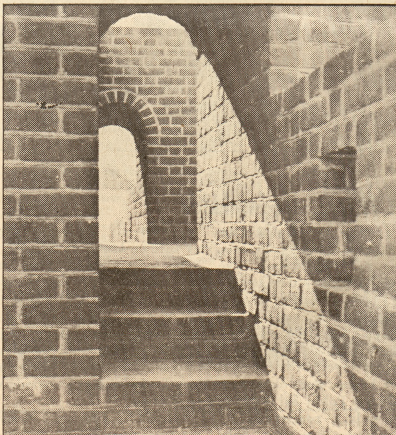
Mury Starej Warszawy — wejście do baszty Prochowej.
