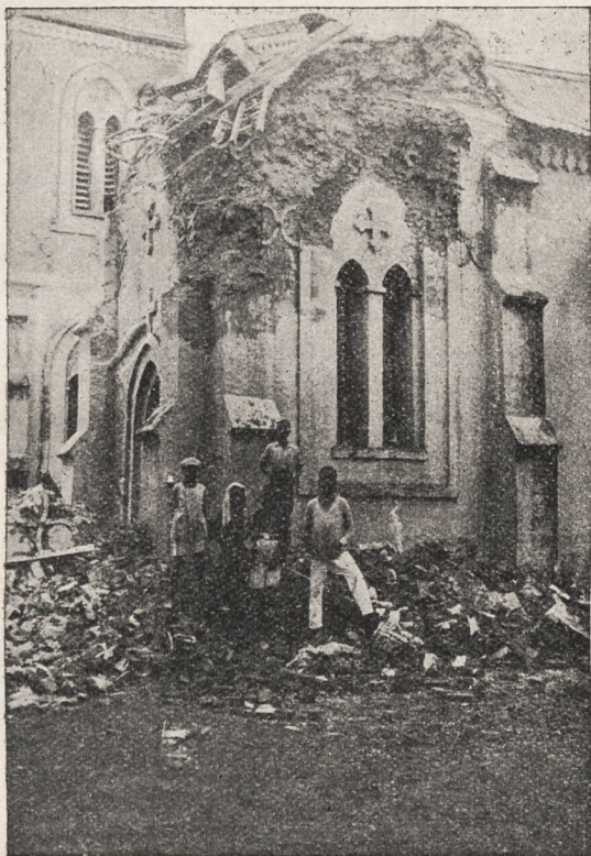
Zawalona wieża w Stanley-Ville.
