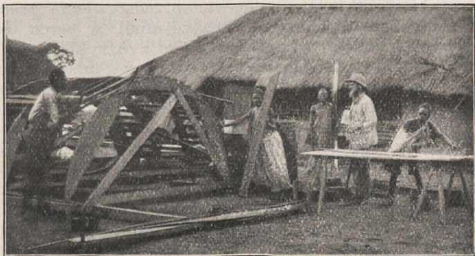
Przy budowie dachu.
