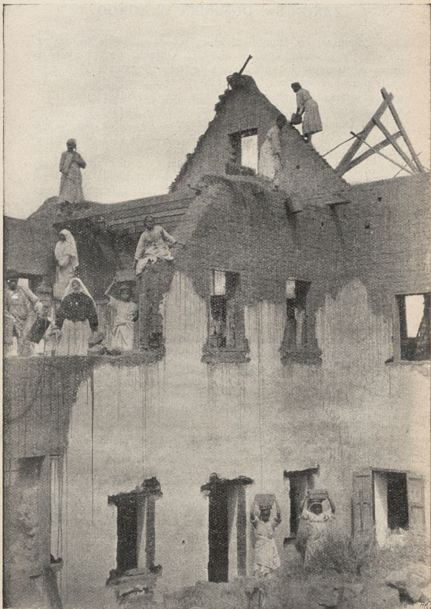
Praca przy budowie zrujnowanej ochronki sierot w Ambatolampy.
