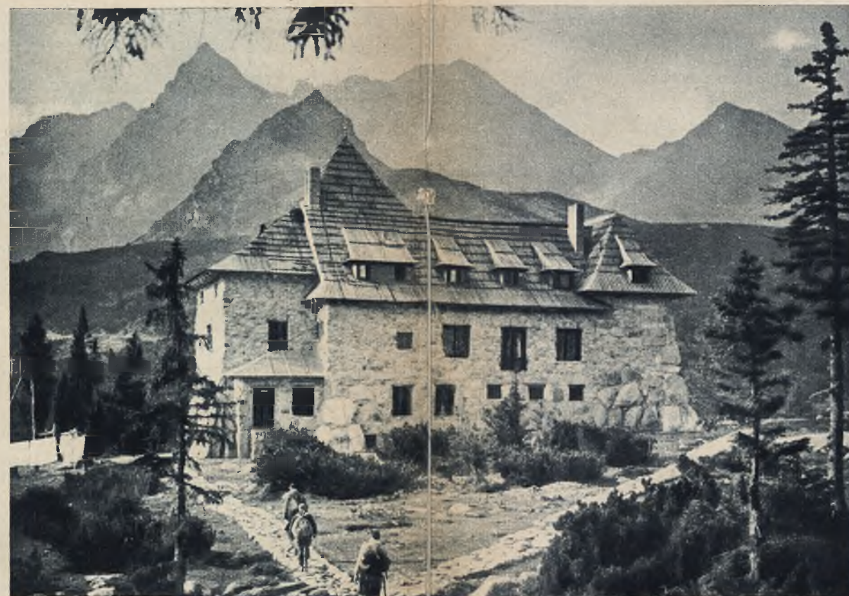
Schronisko Warszawskiego Oddziału P. T. T. na Hali Gąsienicowej (w Tatrach). Typ wielkiego schroniska kamiennego — rozbudowa utrudniona
