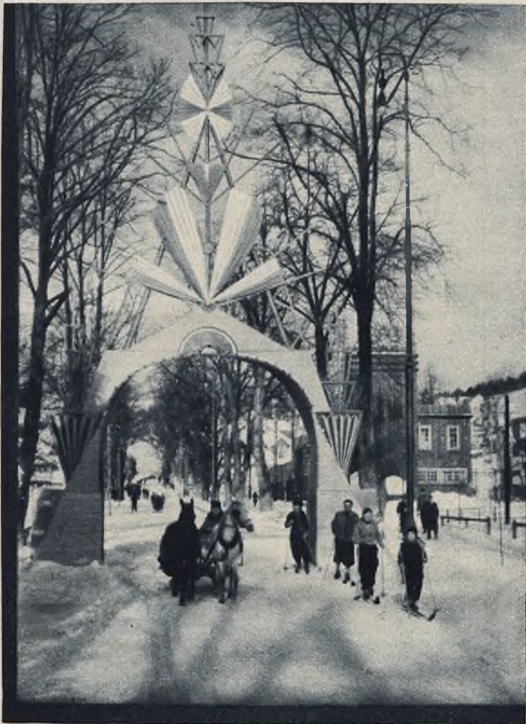
Brama przy wejściu na Stadion w Krynicy
