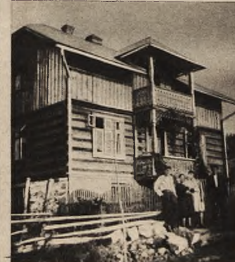
Zły przykład budownictwa
