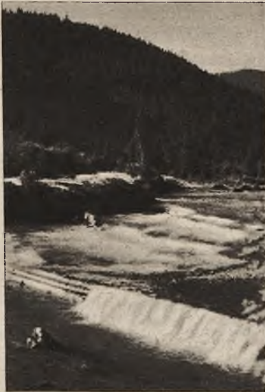
Sztuczne progi piętrzące Fot. Dr. A. Zieliński
