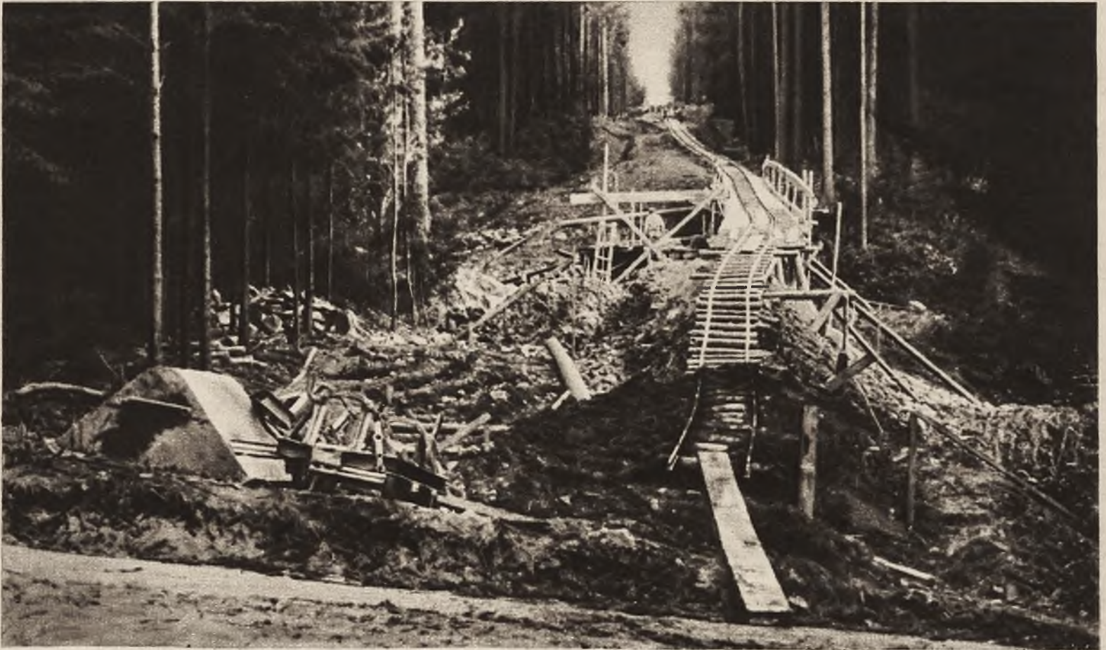
Budowa kolei linowo-terenowej na Górę Parkową w Krynicy.
