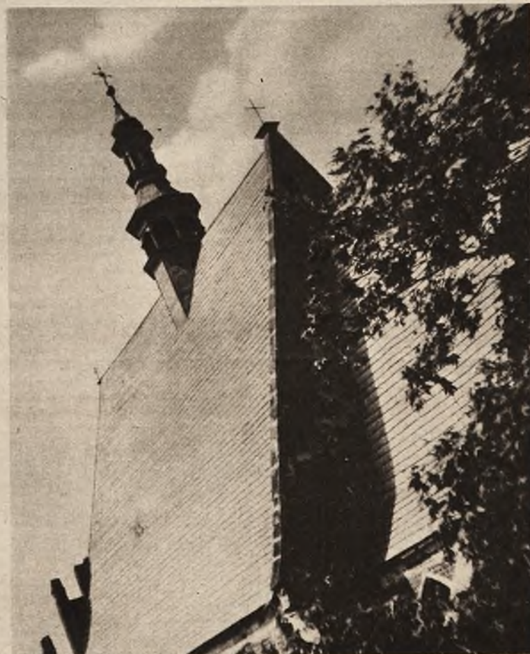
Gontowy dach kościoła.
