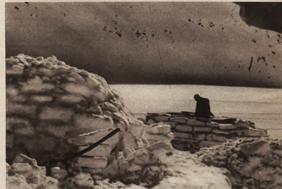
Jeden domek śnieżny już gotów — drugi w budowie.
