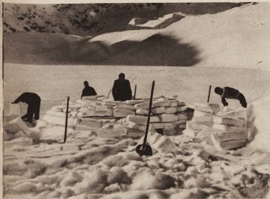
Budowa domku śnieżnego sposobem „schodkowym”.
