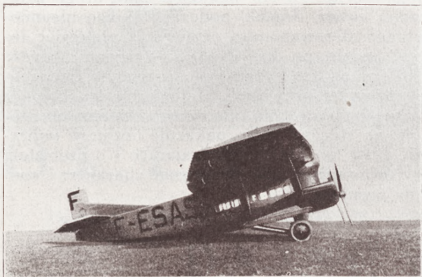
Typ samolotu komunikacyjnego — „Jabiru“ Farmana Rozpiętość—19 m. Długość—13,6. Szybkość max.— 208 km/g. Pułap — 4250. Dwa silniki Lorraine-D. po 400 KM.
