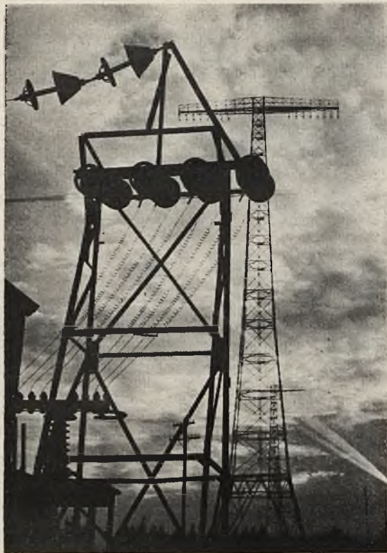
Anteny Radiostacji w Babcicach pod Warszawą, przez które nadawane są audycje krótkofalowe SPW — 22 m. i SPD — 26,01 m. (Jest ich 10, ustawionych w prostej linii w odległości 384 m. jedna od drugiej — wysokość wież antenowych 126 m.).
