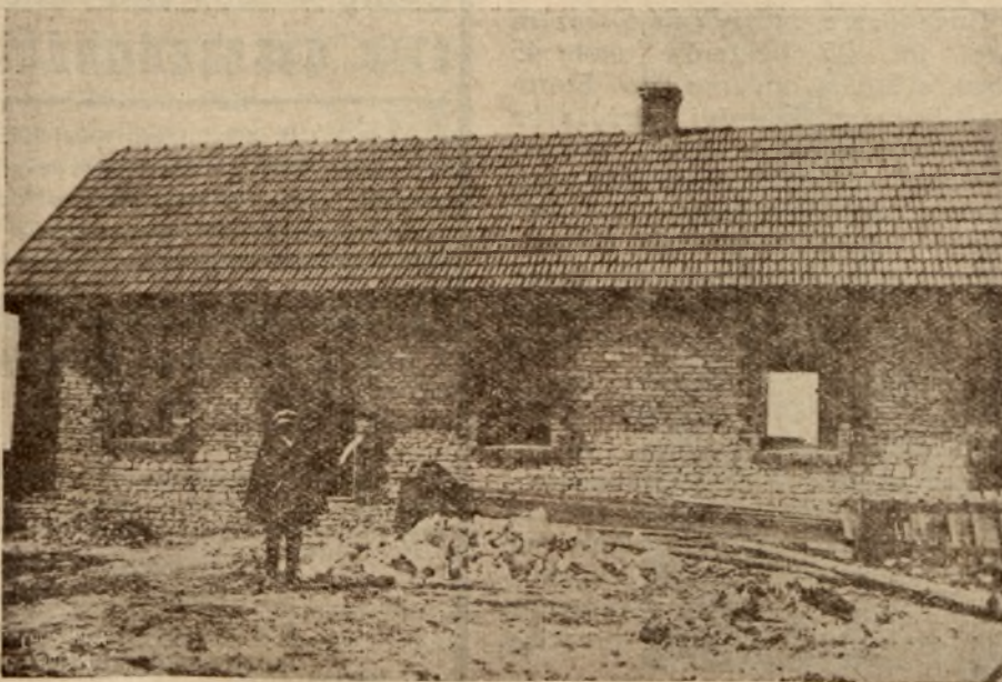
Dom mieszkalny po scaleniu.
