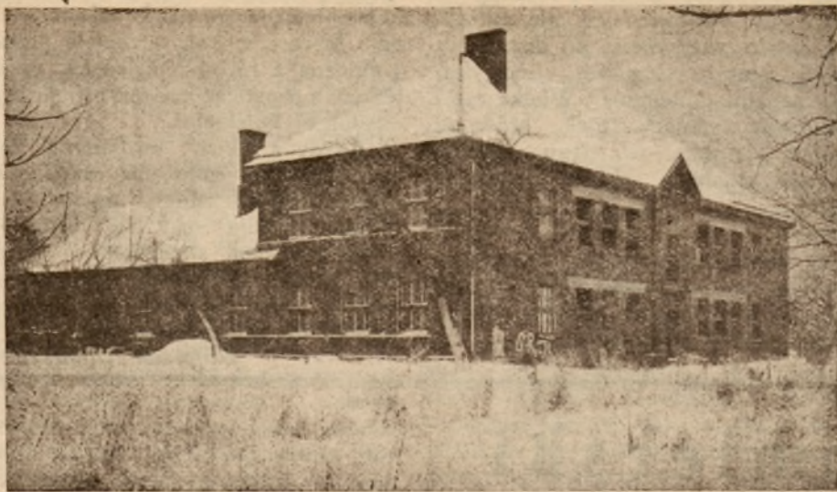
Budowa nowego gmachu szkoły rolniczej żeńskiej im. królowej Jadwigi w Mokoszyń.
