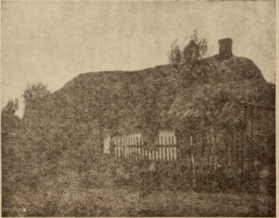
Dom mieszkalny przed scaleniem.
