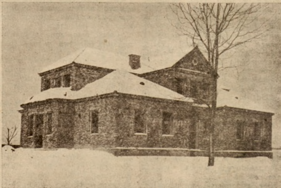
Budowa nowego gmachu Rolniczego Zakładu Doświadczalnego w Zdanowie.
