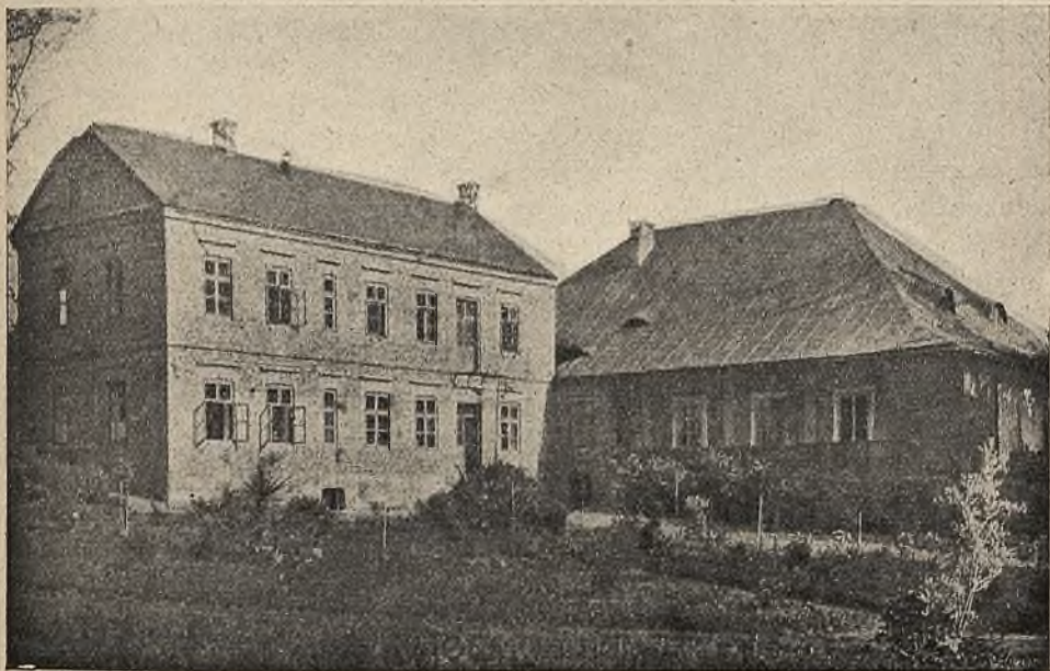
Fragment Kolegium Zgromadzenia Św. Michała Archanioła w Pawlikowicach.
