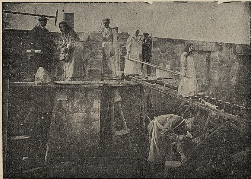
SS. Michalitki przy budowie Zakładu swego w Miejscu-Piastowem.
