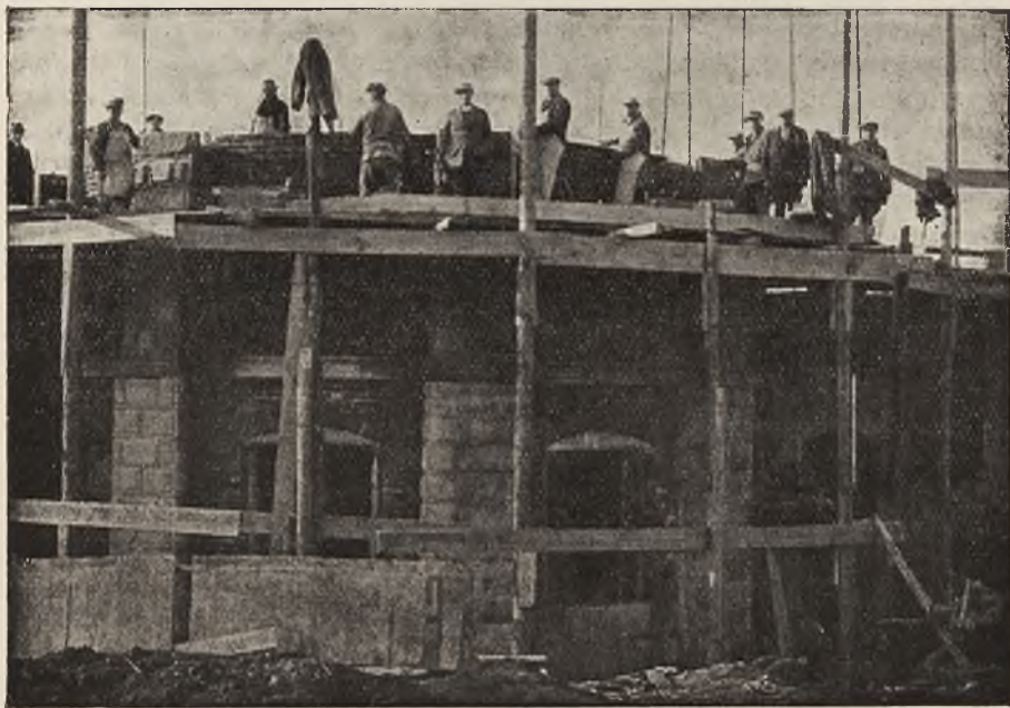
Fragment budowy kaplicy Zakładowej.
