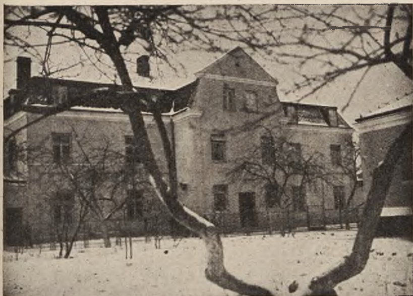
Zakład w Strudze. Dom I.
