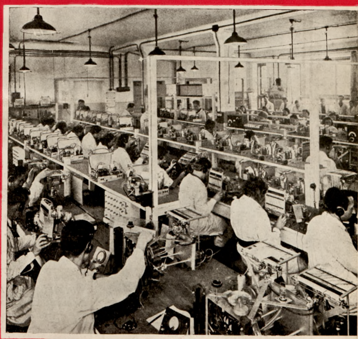
Hala strojeń w fabryce Krajowych Zakładów Telefunken
