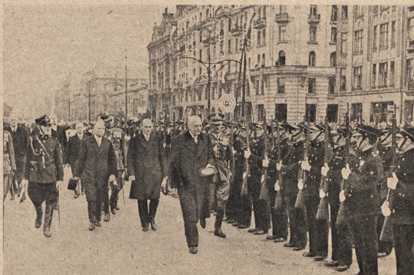
Pan Prezydent przechodzi przed frontem kompanji honorowej przysposobienia kolejowego, w dniu uroczystego otwarcia tunelu dworca głównego w Warszawie.
