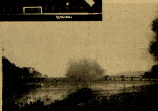
Niszczenie mostu drogowego
