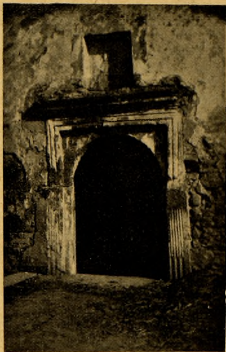
Portal dworu obronnego (XVI w.)
