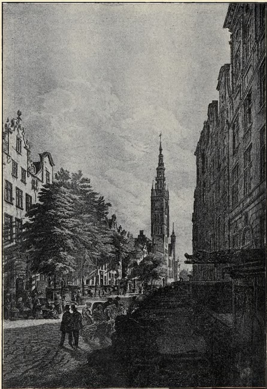
Gdańsk. Długa ulica wedle ryciny J. Schultza z r. 1842. Widoczne jeszcze przedproża. W głębi Ratusz.
