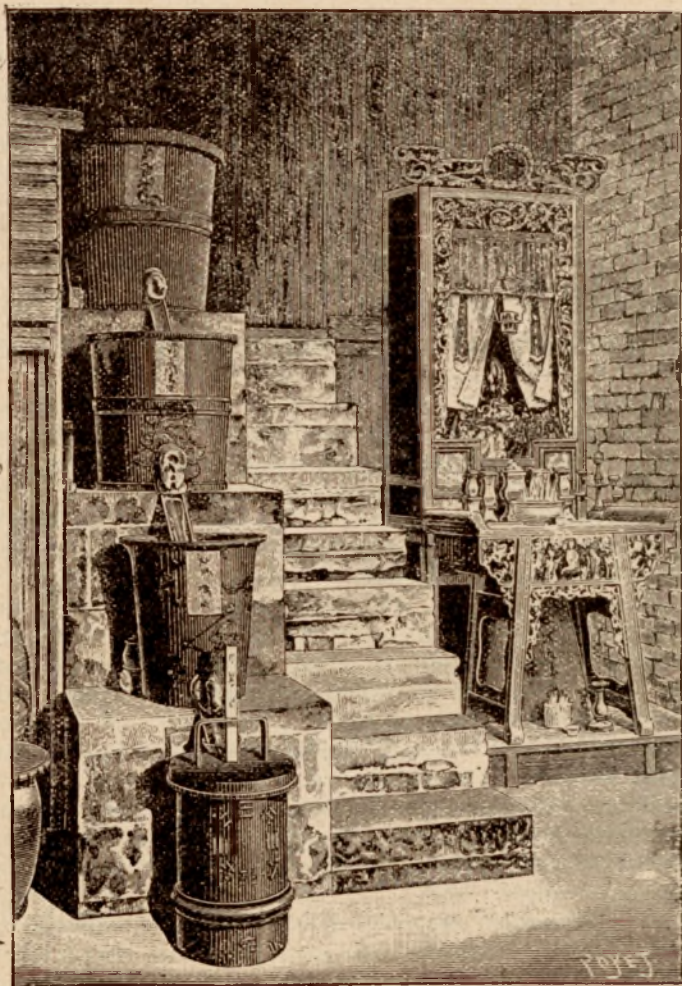
Rys. 1. Typowy archaiczny zegar wodny, istniejący jeszcze w Kantonie w Chinach.
