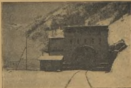
Tunel Simploński od strony szwajcarskiej.
