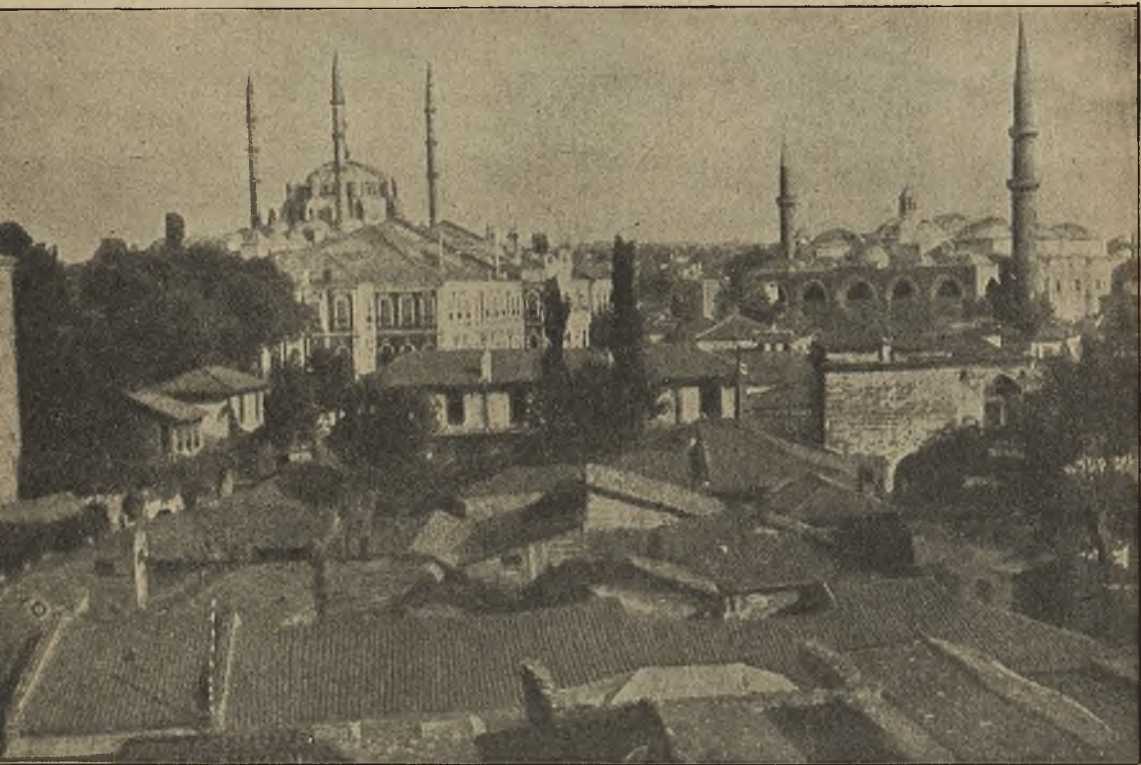
Ogólny widok Adrianopola, oblężonego przez Bułgarów.
