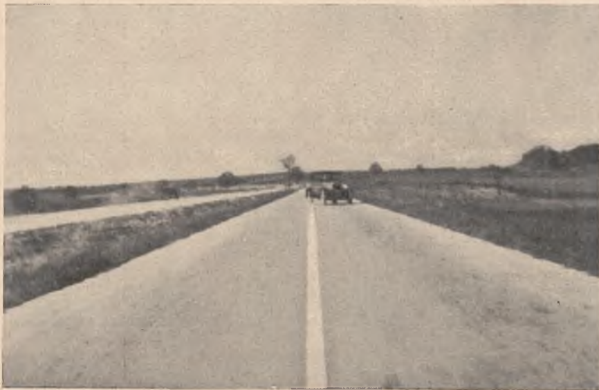
Na idealnej poziomej, betonowanej drodze dokonywane są próby, mające na celu stwierdzenie łatwości kierowania wozem przy różnych szybkościach.
