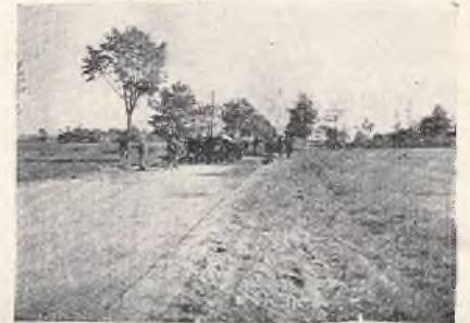
Budowa nawierzchni komdrobitowych na od-cinku Cieszyn — Bielsko.
