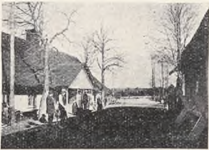
Budowa nawierzchni komdrobitowej na od-cinku Skoczów — Ustroń.
