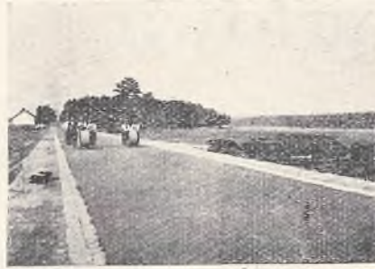
Budowa nawierzchni komdrobitowej na od-cinku Skoczów — Ustroń.
