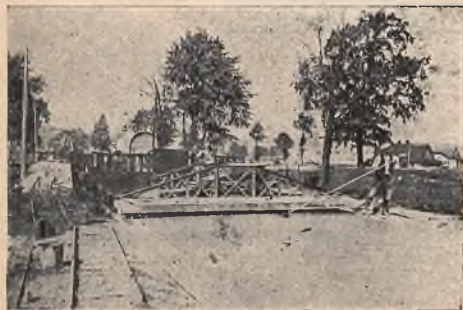
Układanie betonowej nawierzchni postępuje niezwykle szybko.
