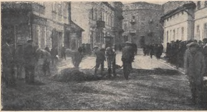
Układanie nawierzchni Warrenite - Bitulithic na ulicach m. Stanistawowa.
