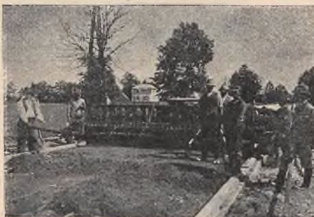
Układanie nawierzchni betonowej wymaga nielicznego personelu.
