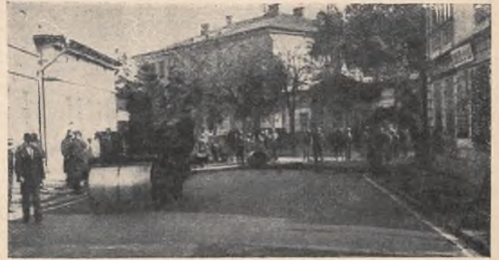
Układanie nawierzchni Warrenite - Bitulithic na ulicach m. Stanistawowa.
