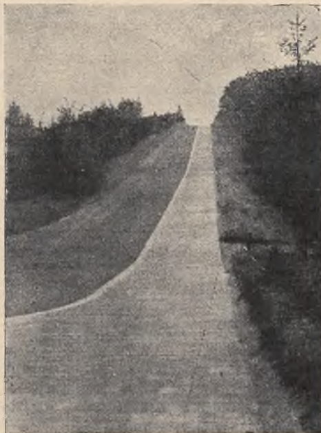
Nawierzchnie betonowe doskonale pracują na stromych wzniesieniach.
