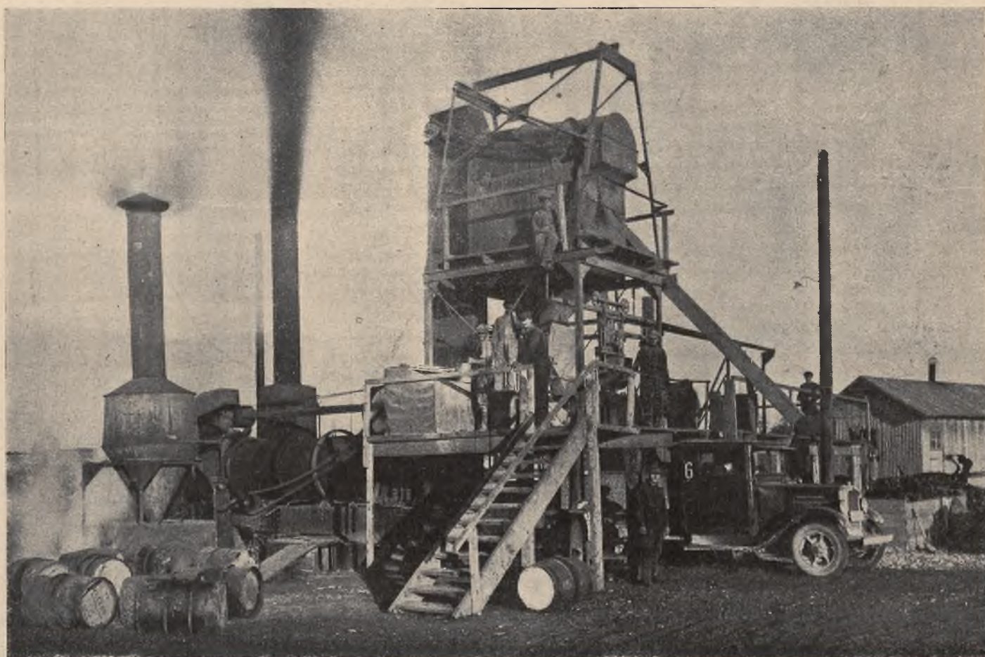
Powyzsza ilustracja przedstawia zespól maszyn do wyrobu mieszaniny asfaltowej, ustawiony w Stanistawowie przez firmę «Trwate Drogi Sp. Akc.» w związku z budowà nawierzchni ulicznych. Ta instalacja przewoźna pozwala ułożyć do 1600 m 2 dziennie nawierzchni «Warrenite - Bitulithic».
