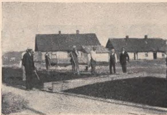
Budowa nawierzchni z „limbitu“ (wałowanie ręcznymi wałkami)
