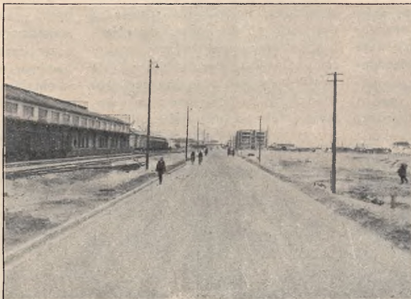
Gdynia - Port. Pierwsza droga asfaltowa w porcie, od Chłodni do Cukroportu. Ułożona przez Sp. Akc. STRADA z zimnego asfaltu systemu «Colprovia» z materiałów wyłącznie krajowych.
