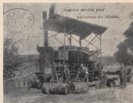
Instalacja do fabrykacji emulsji asfaltowej systemu „Ejalg”. Wydajność 15 ton na godz.
