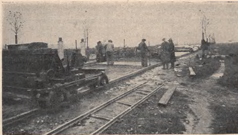
Stosowanie nowoczesnej organizacji pracy przy układaniu nawierzchni betonowej na szosie Wilanowskiej.
