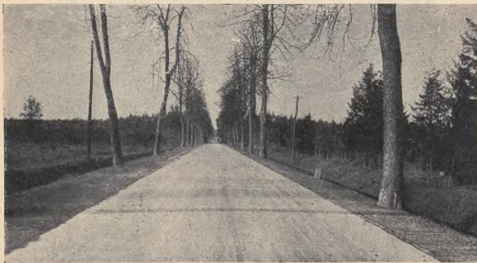
Nawierzchnia Warrenite-Bitulithic ułożona w r. 1929 na drodze Kobiór — Pszczyna (G. Śląsk).
