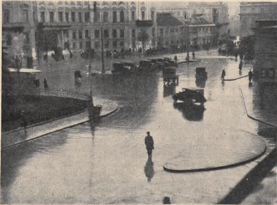
Nawierzchnia z asfaltu walcowanego, o powierzchni 7300 m 2 ułożona na Placu Teatralnym w r. 1930. przez firmę Sieczko i Balinger
