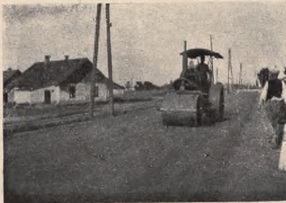
Budowa nawierzchni z „limbitu“ (wałowanie wálkiem 9 ton)
