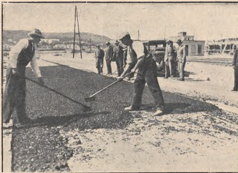
Układanie nawierzchni z zimnego asfaltu angielskiego systemu «Colprovia» w porcie Gdyni.
