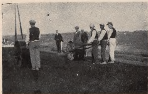
Budowa nawierzchni z „limbitu“ (rozścielanie i równanie materiału)
