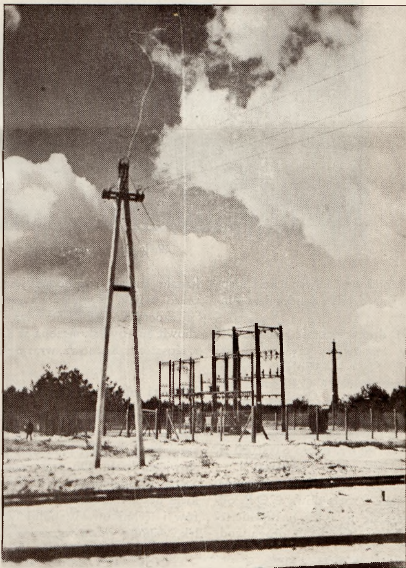
Stalowa Wola — Zakłady Przemysłowe — przewody wysokiego napięcia.
