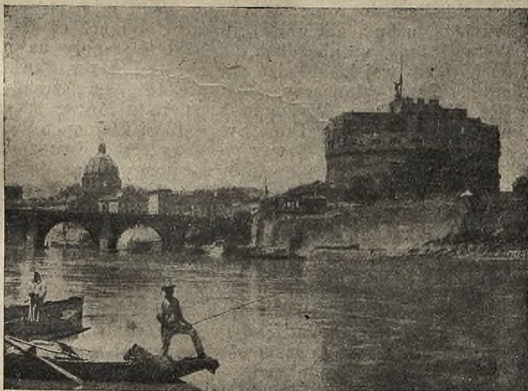
Zamek św. Anioła nad rzeką Tyber w Rzymie — dawniej grobowiec cesarzy rzymskich, później forteca papieska. Za mostem widać kopułę Bazyliki św. Piotra.
