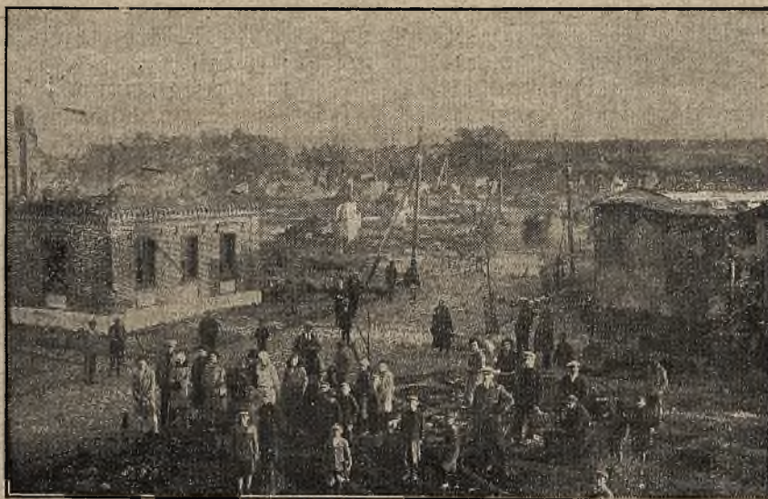
Pożar w Kurzeniecu. Ogólny widok pogorzeliiska.
