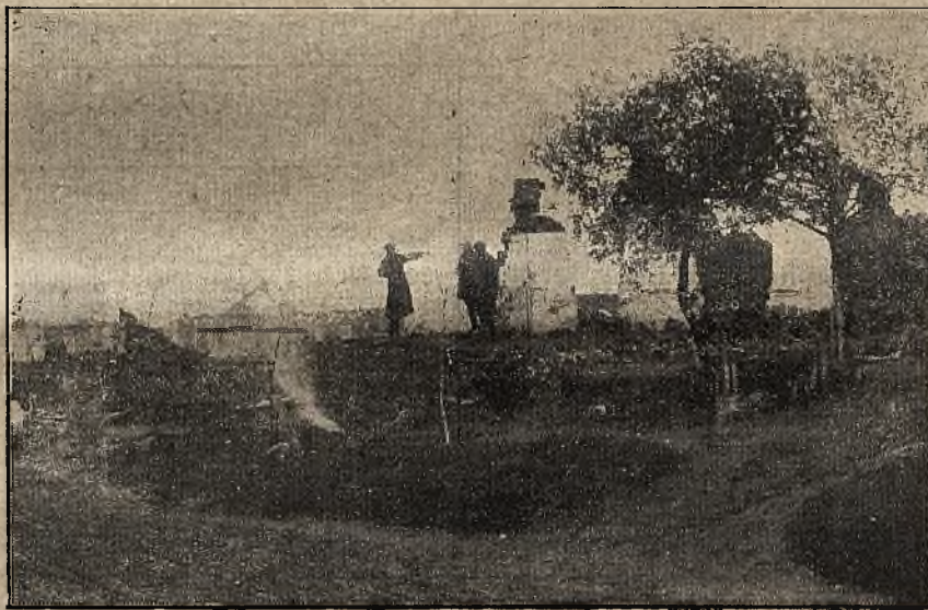
Ulica Smorągńska, miejsce z którego rozpoczął się pożar.
