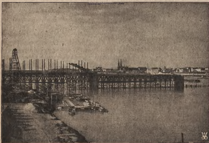
Nowy most kolejowy. Roboty przy budowie mostu t zw. linii średnicowej węzła warszawskiego u wylotu tunelu szybko postępują naprzód.
