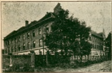
Zakład naukowo wychowawczy SS. Urszulanek w Kołomyi. Widok od strony północno-zachodniej.
