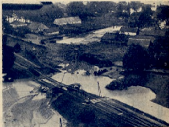
Przerwany tor kolejowy pod Biadolinem przez wylew Dunajca
