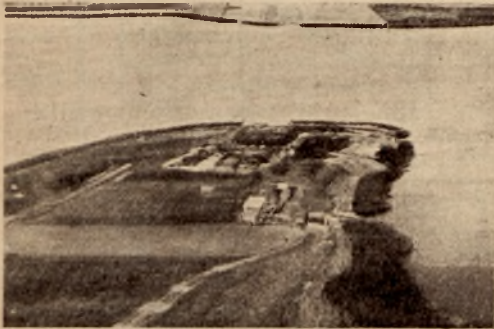
Widok półwyspu z lotu ptaka w czasie wykopywania w 1935 r.
