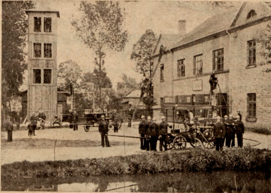
Drużyna OSP Blachownia podczas ćwiczeń na tle nowej remizy.
