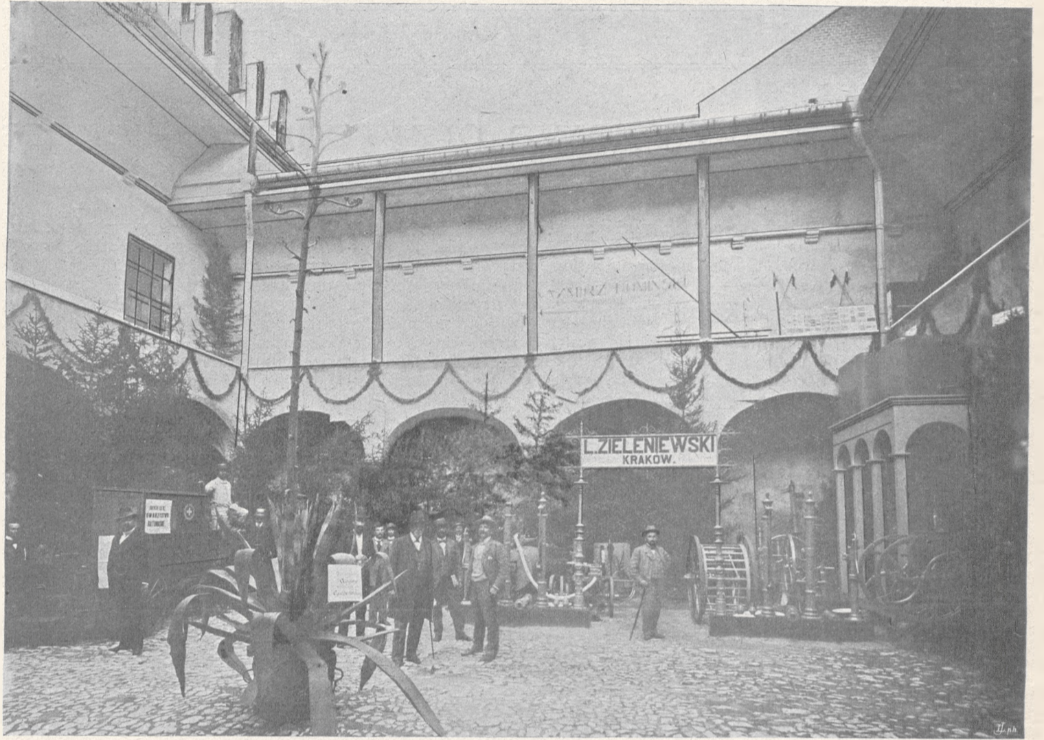
Podworec z Pogotowiem ratunkowym i pawilon L. Zieleniewskiego. (Łazienki ludowe i części wodociągowe) odznaczone wielkim złotym medalem
