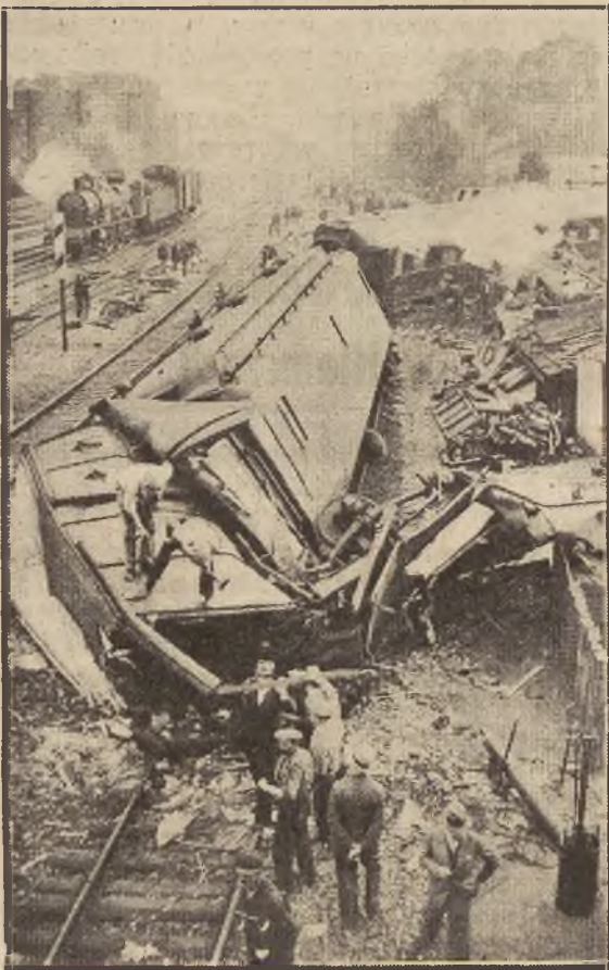
Z boku: Na miejscu strasznej katastrofy kolejowej pod Paryżem, w której zginęło 29 osób, 50 zaś odniosło poważne rany.
