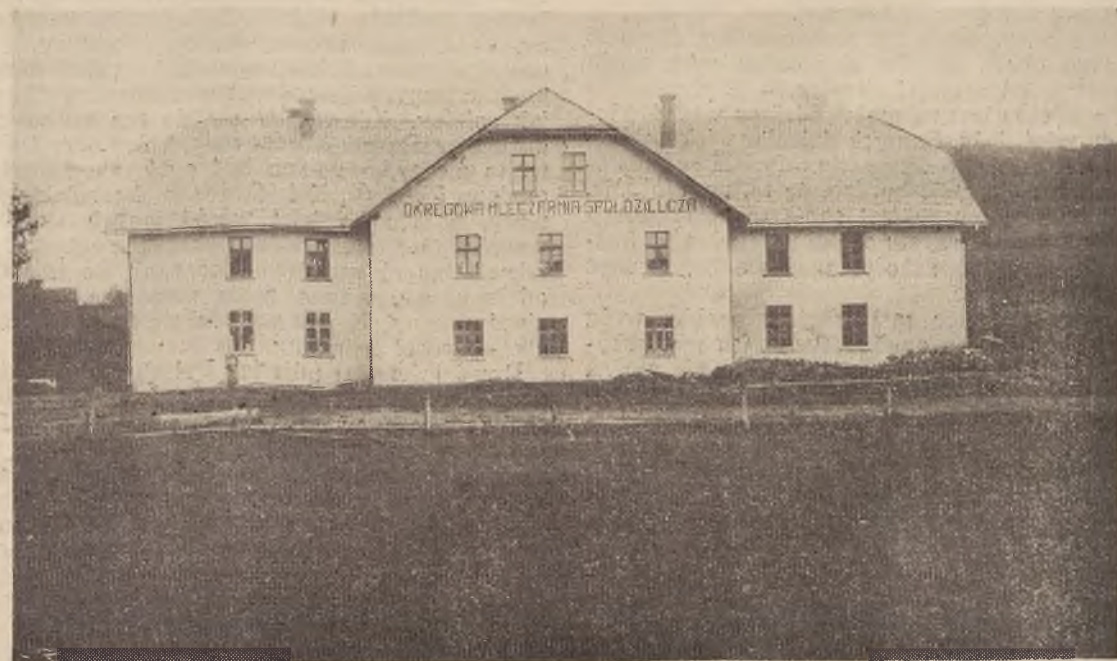
Gromadnym, zjednoczonym wysiłkiem mieszkańców powstał oto ten gmach Okręgowej Spółdzielni Mleczarskiej we wsi Łużnej w woj. łwowskim, która wykuwa sobie coraz lepszy byt i kulturę drogą zjednoczonej pracy pod błękitnym sztandarem spółdzielczym.
