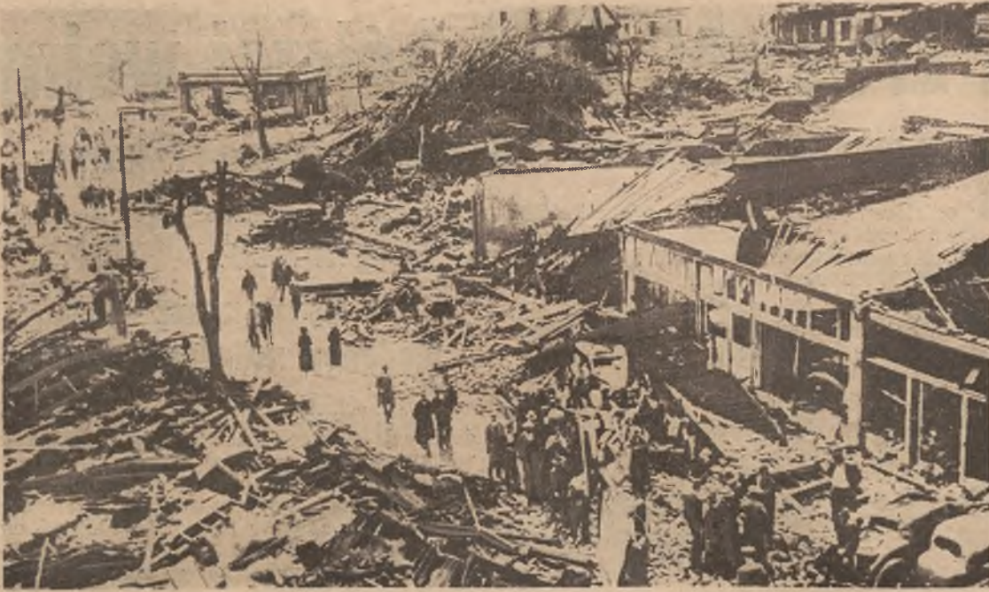
Na fotografii powyższej widzimy straszne skutki trzęsienia ziemi w Chile. Kolumny ratownicze wydobywają spod gruzów domostw zabitych i rannych. Piszemy o tym obszernie na innym miejscu.
