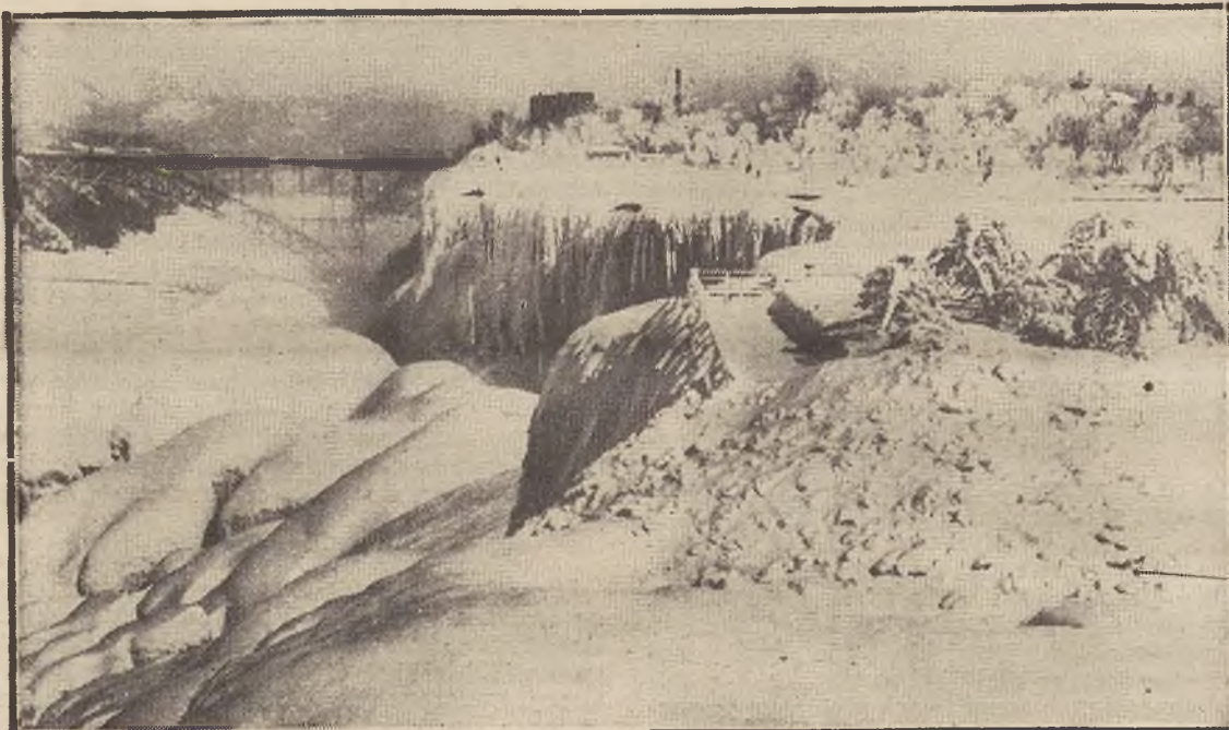
Pod naporem zwalów lodowych runął w przepaść, widoczny na dalszym planie, żelazny most łukowy nad słynnym wodospadem Niagary w Stanach Zjednoczonych.
