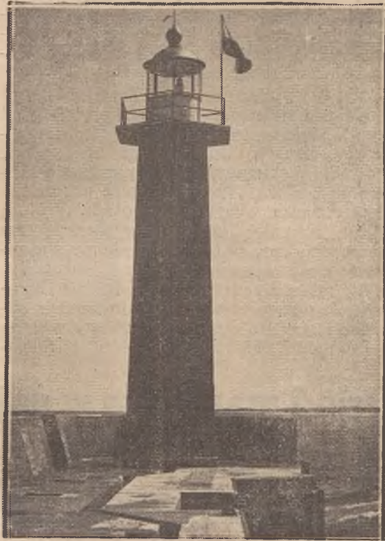
Latarnia morska przy wjeździe do portu rybackiego Władysławowo
